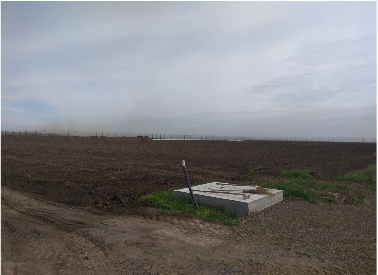
A tervezett telephelybővítés lekerítve, humuszosításra előkészítve. Előtérben a belső közműhálózat.
